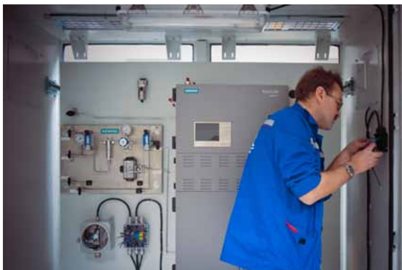
▲ Монтаж аналитической системы для Сызранского НПЗ
